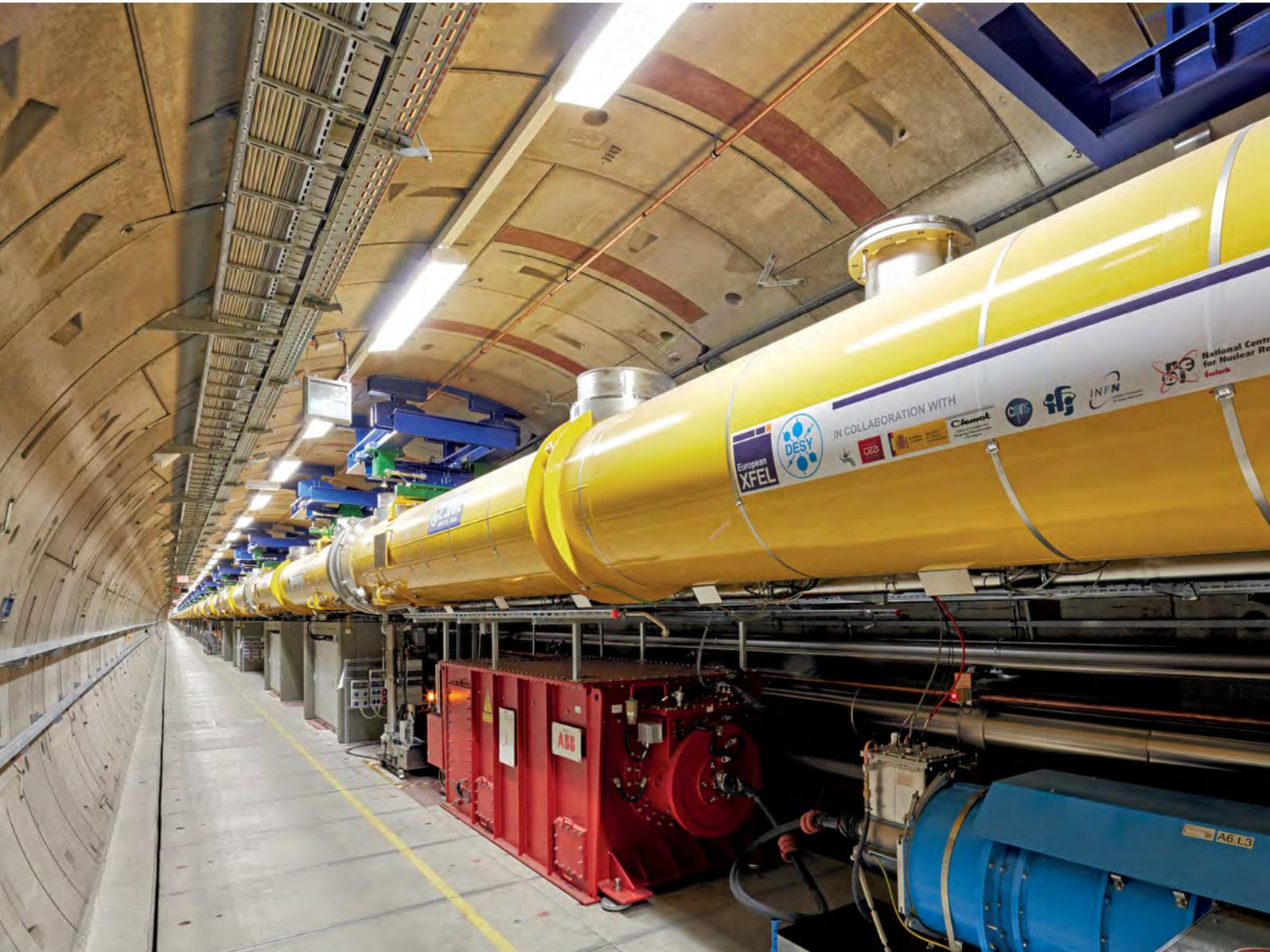
Der supraleitende Linearbeschleuniger des European XFEL, der längste weltweit, beschleunigt die Elektronen auf hohe Energien.
