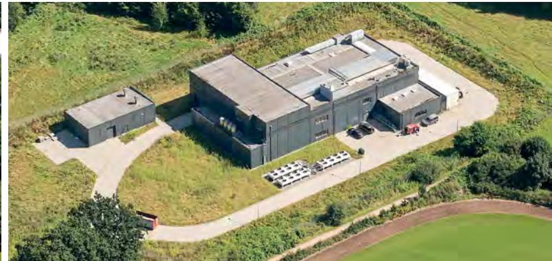
Das Betriebsgelände Osdorfer Born im August 2017. Unter dem Hallengebäude liegt das Schachtbauwerk XS1, das auf seinem Grund den Beschleunigtunnel mit den beiden ersten Undulatortunneln verbindet. Weitere Gebäude dienen der Versorgung mit Energie und Wasser sowie der Klimatisierung.
